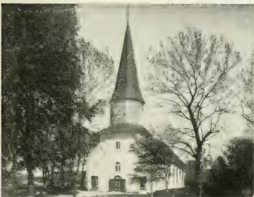
Fig. 252. Oddernes kirke med taarn bygget 1689.
